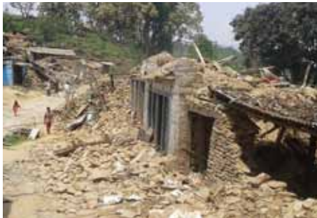
Ein beschädigtes Haus in Masel (Foto: Bagale)
